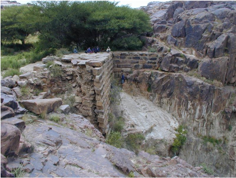
صور رقم (٣). جدار سد الحاصر قبل إضافة الجزء الحديث
