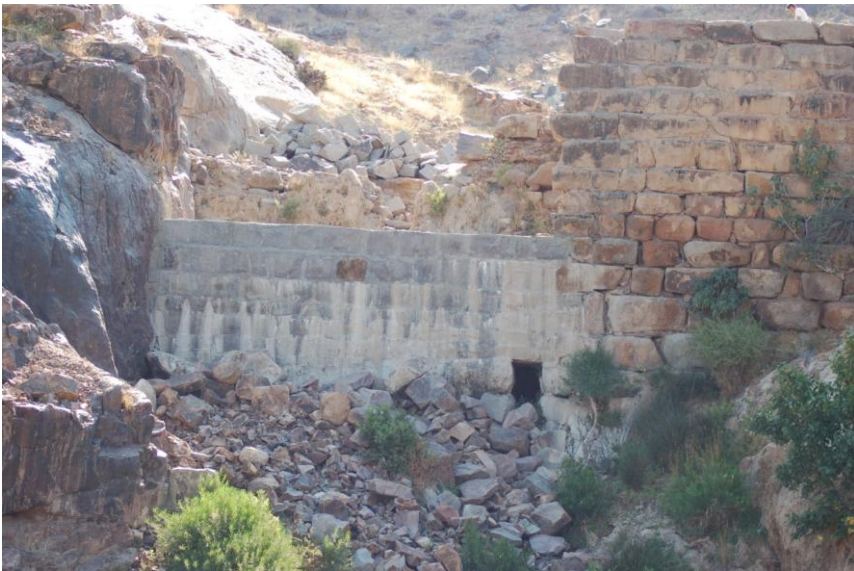
صورة مكررة رقم (٤) تبين الإضافة الحديثة في جدار سد الحاصر.
