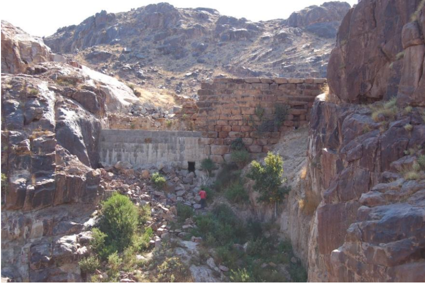
صورة رقم (٤). جدار سد الحاصر بعد إضافة الجزء الحديث.
